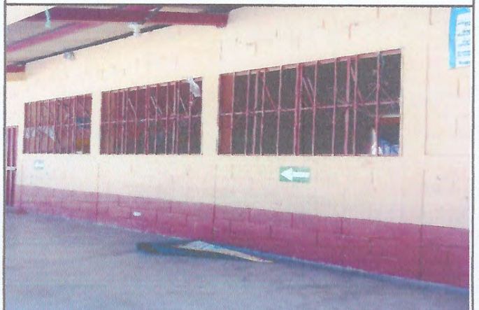
Foto 4: Ventanas de aulas
